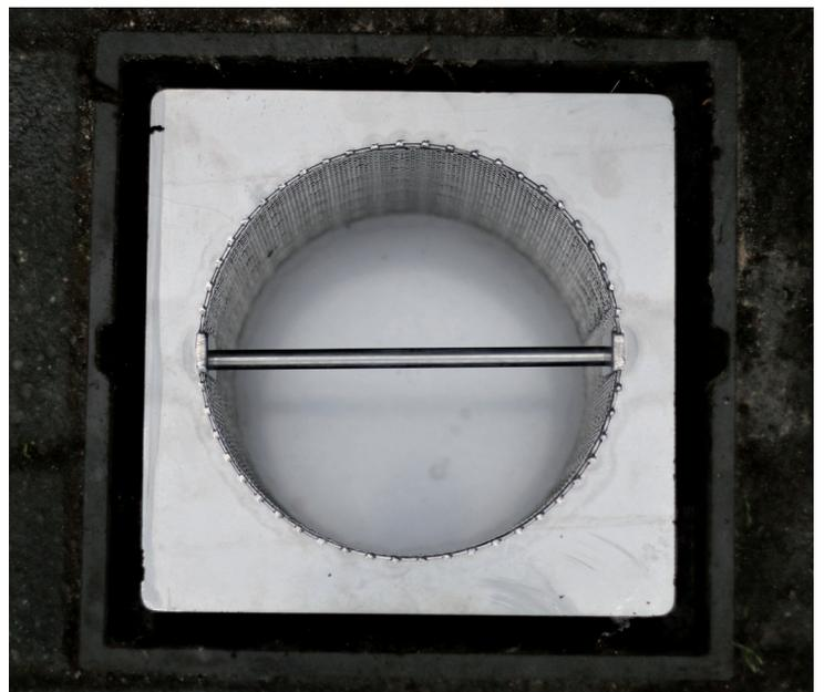
Plastikfangkörbe helfen den Verlust von Plastikrückständen zu reduzieren.
